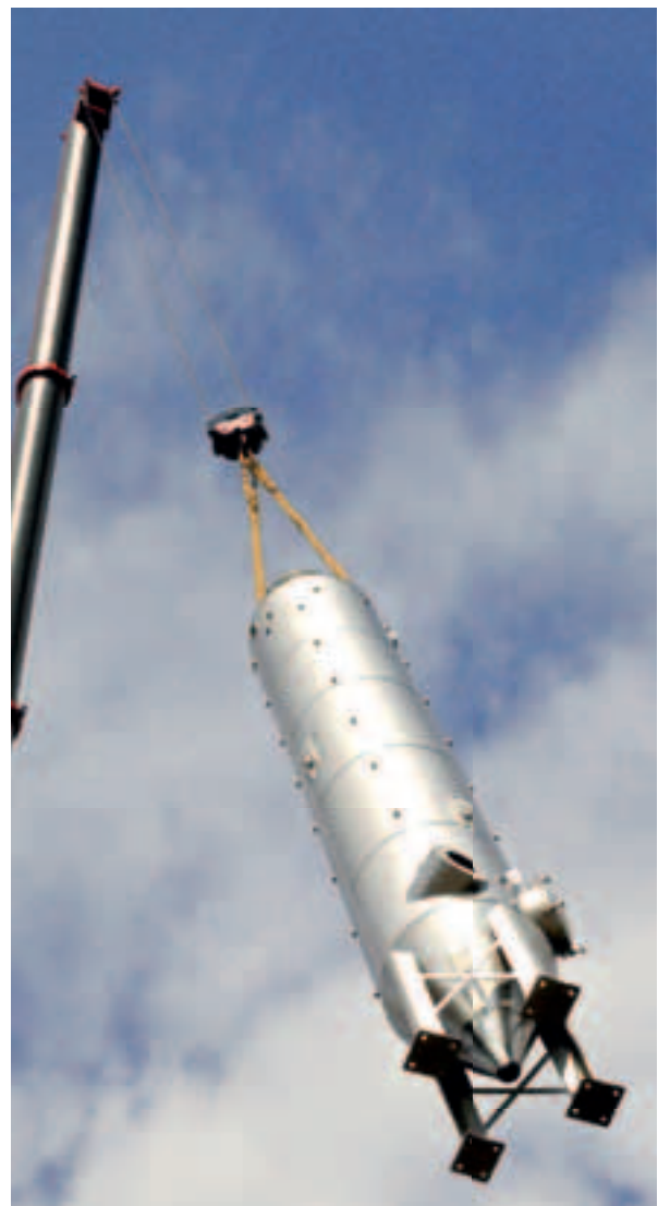
Installation d'un tube de filtration dans un bâtiment d'usine
