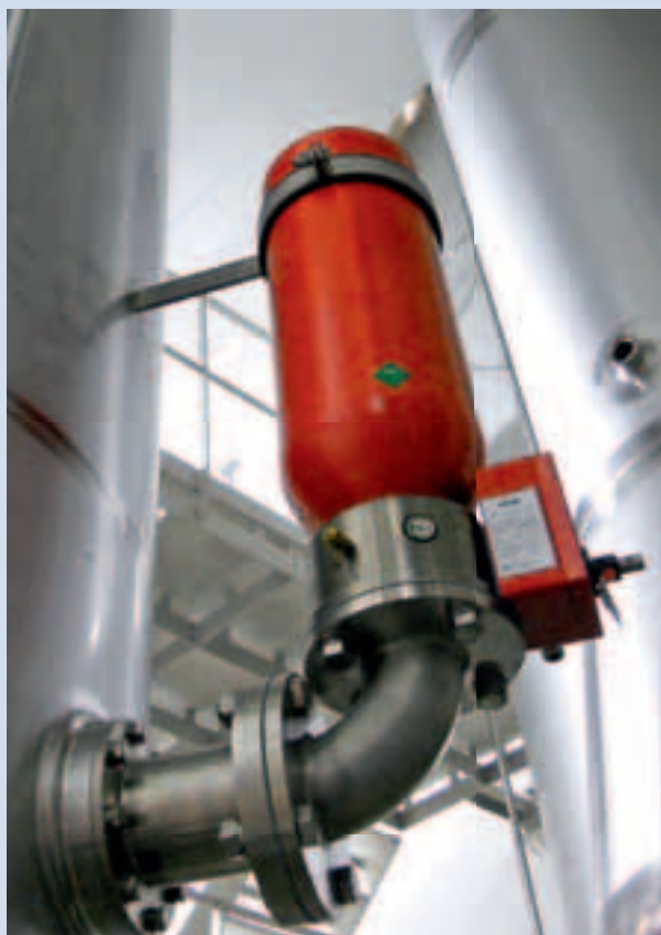
Sécurité additionnelle à travers un système anti-explosion des poussières
