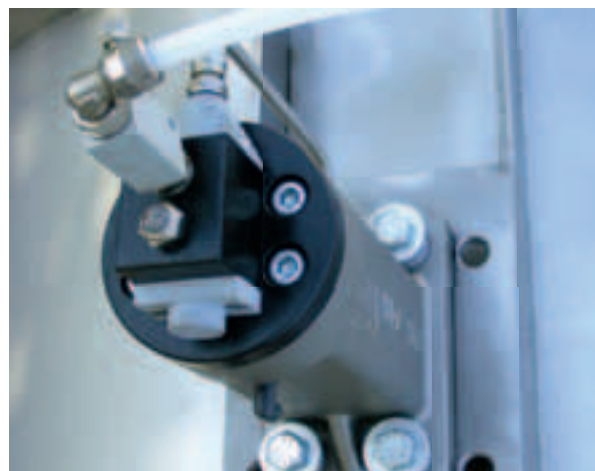
Marteaux pneumatiques sur les parois extérieures du filtre tubulaire
